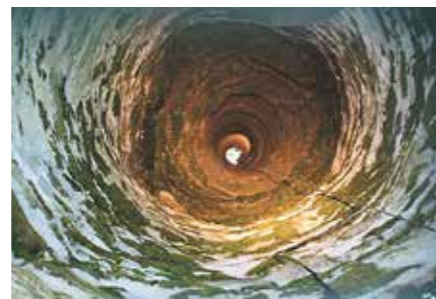
Der Sodbrunnen lässt tief blicken.
