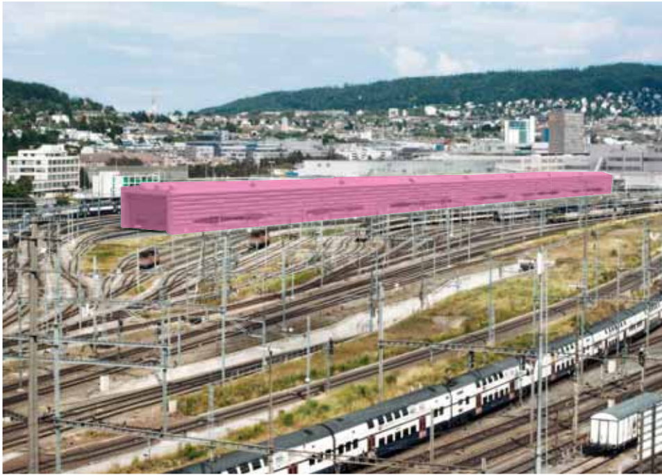
Photovoltaik auf dem Dach: Ab 2014 werden hier die neuen Doppelstockzüge gewartet.
